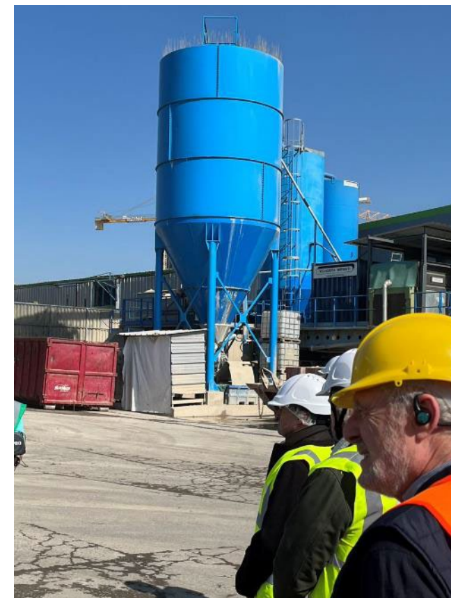
Silos stockage et filtrage des boues de forages géothermiques
